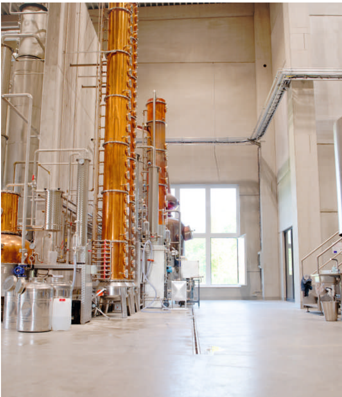
In der Destillerie Farthofer wurden 4 Stück Bodenabläufe Eurosink Junior Typ300, 2 Linien randverstärkte Schlitzrinnen inklusive Bodenablauf DN100 und 1 Stück randverstärkte Bodenwanne 500x500 verbaut.
