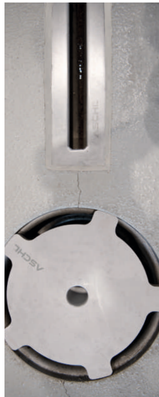
In der Destillerie Farthofer wurden 4 Stück Bodenabläufe Eurosink Junior Typ300, 2 Linien randverstärkte Schlitzrinnen inklusive Bodenablauf DN100 und 1 Stück randverstärkte Bodenwanne 500x500 verbaut.
